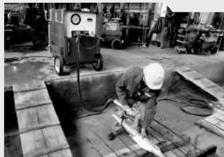
3 Оборудование для преднапряжения арматуры
